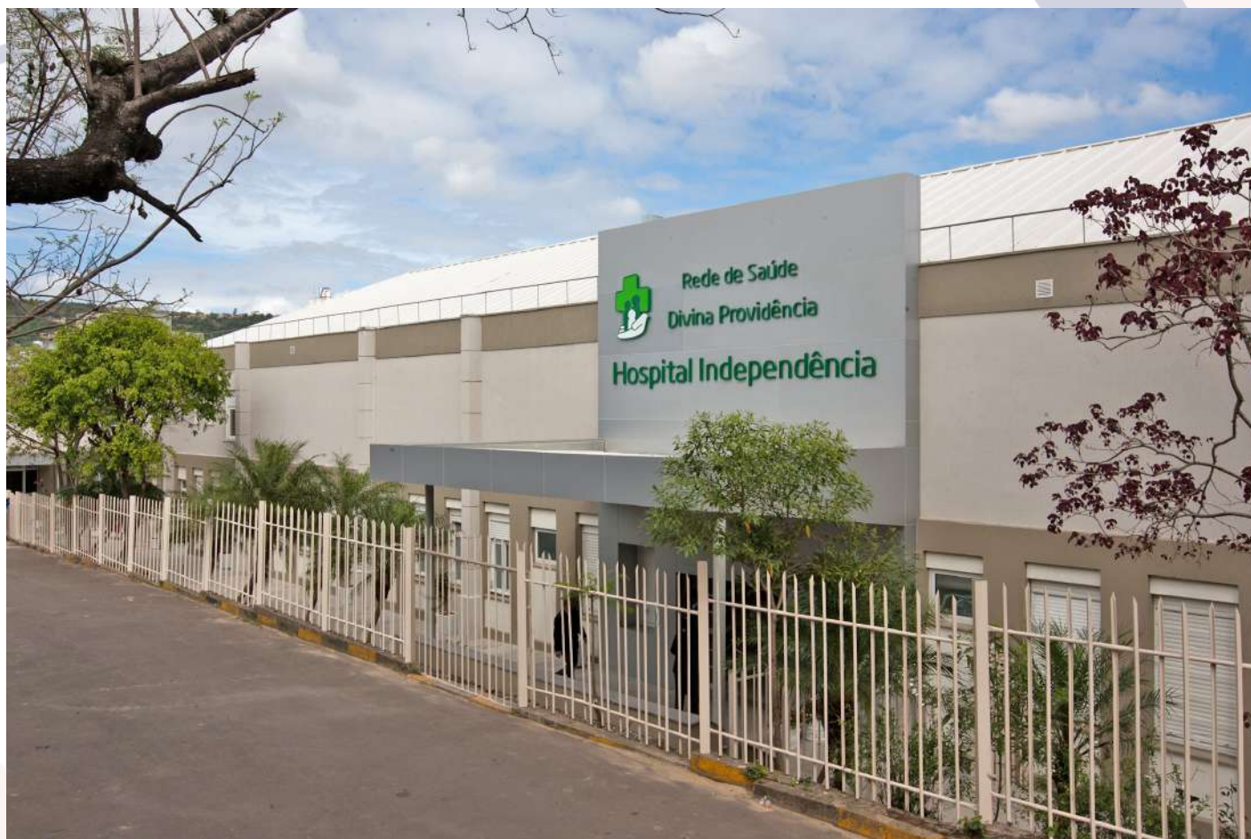
Foto 21: Fachada. Fonte: acervo fotográfico da Formas & Efeito.
