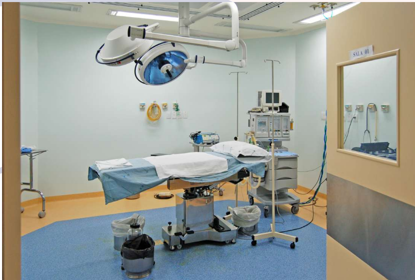
Foto 14: Bloco Cirúrgico do Hospital Dom João Becker, localizado em Gravataí/RS. Fonte: acervo fotográfico da Formas & Efeito.
